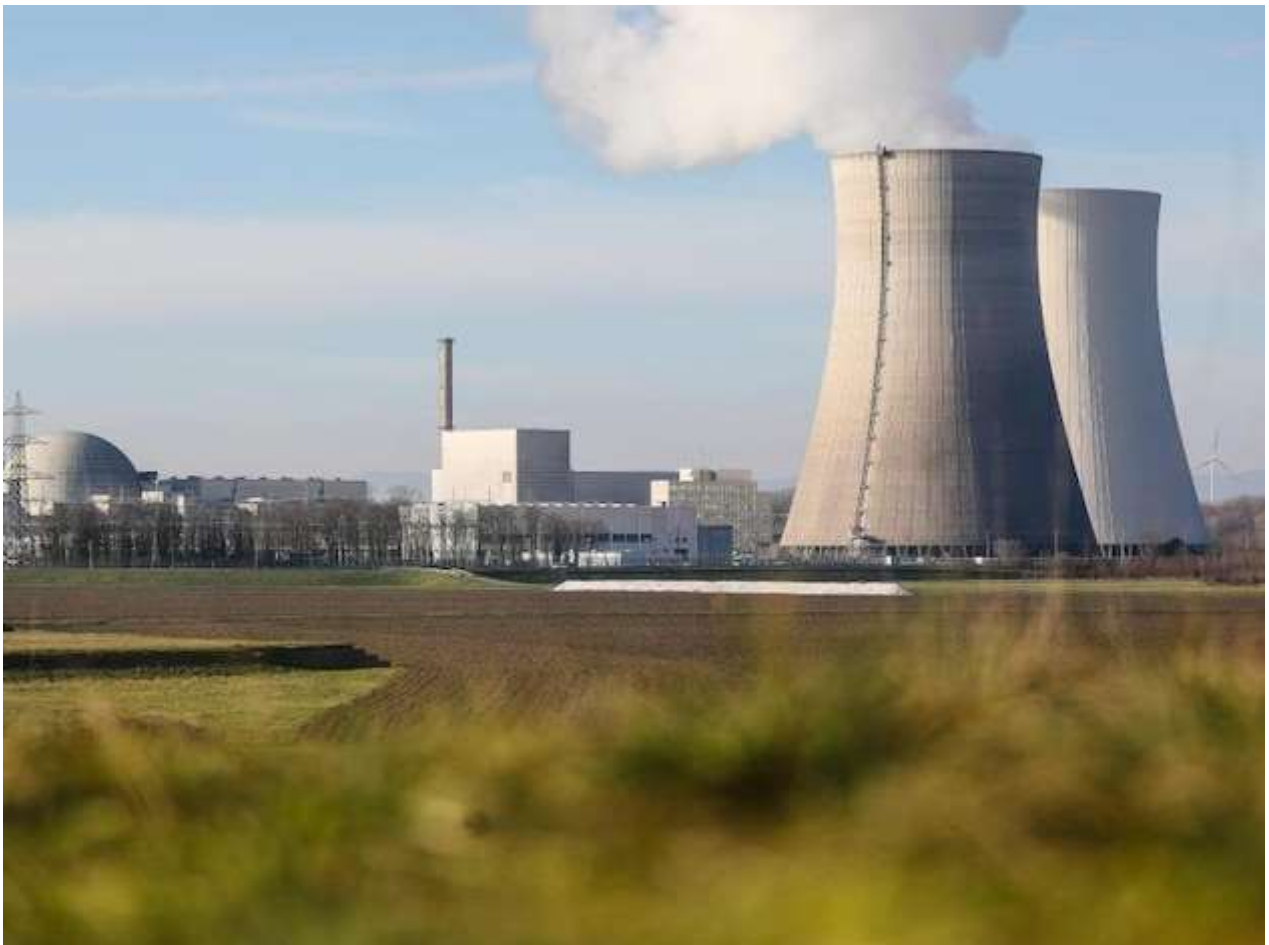
dpa/Christoph Schmidt/dpaWasserdampf über einem Kühlturm des Kernkraftwerks in Philippsburg.
